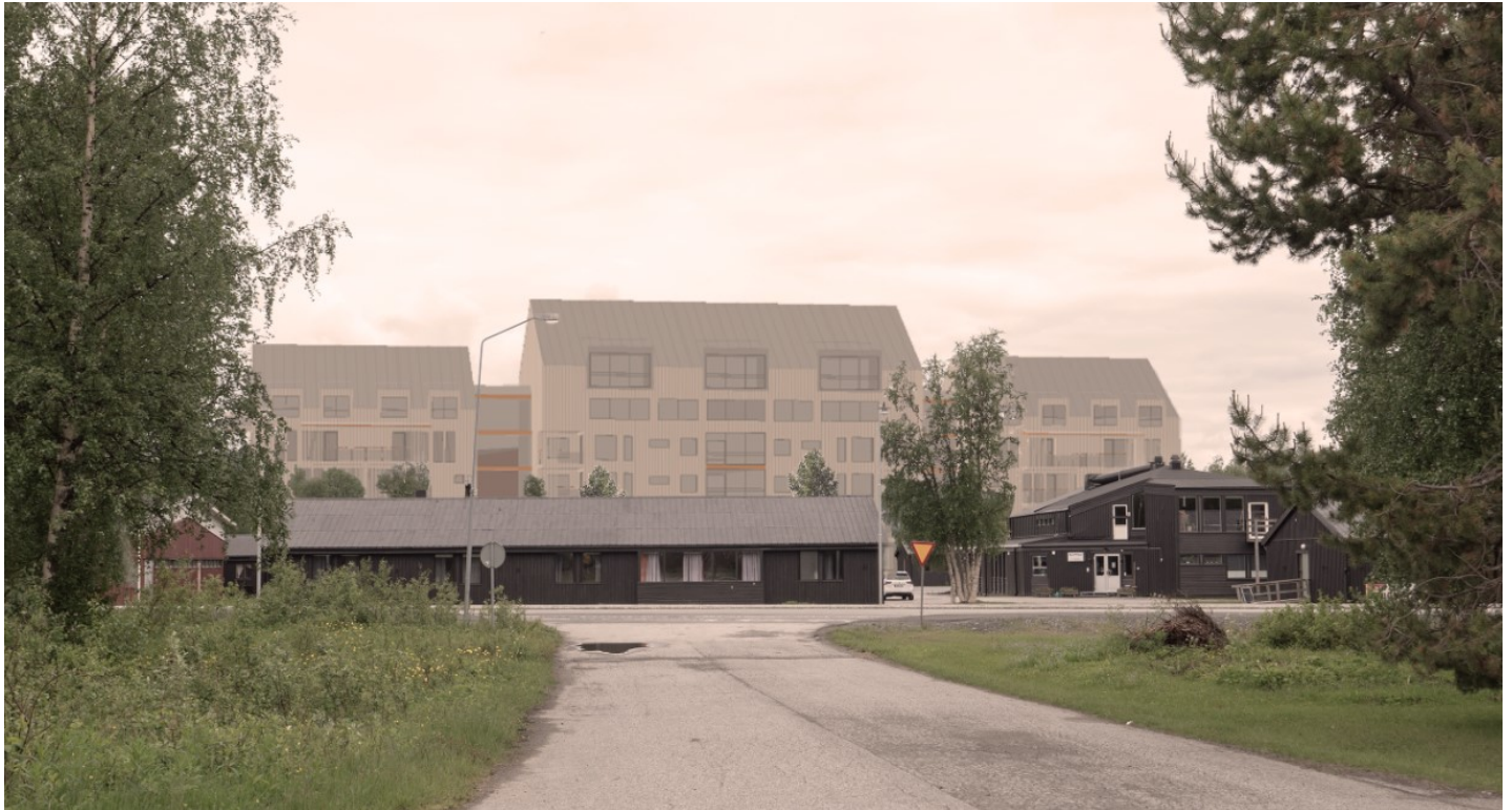
Vy-bild från Skogsvägen, tilltänkta byggnationer i bakgrunden, öster om planområdet och väg E12 och riktning mot väster.
