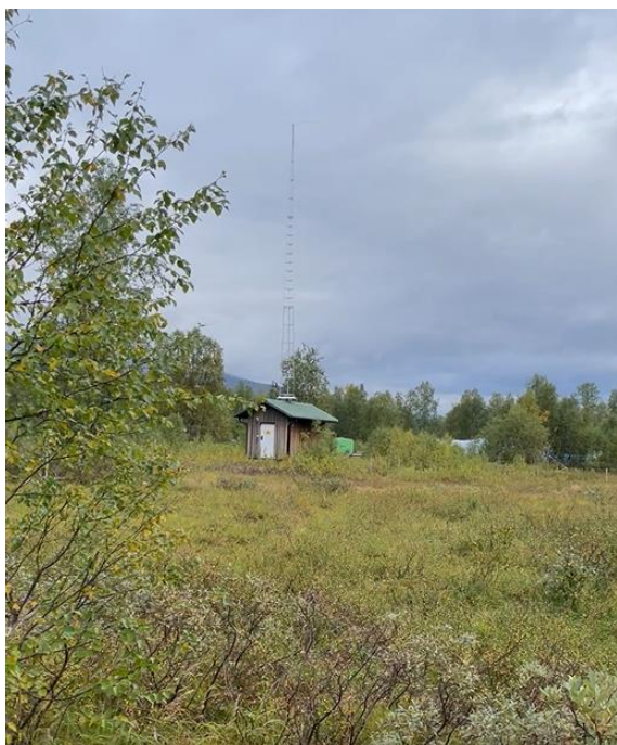
Foto på flygmast och tillhörande teknikbyggnad
