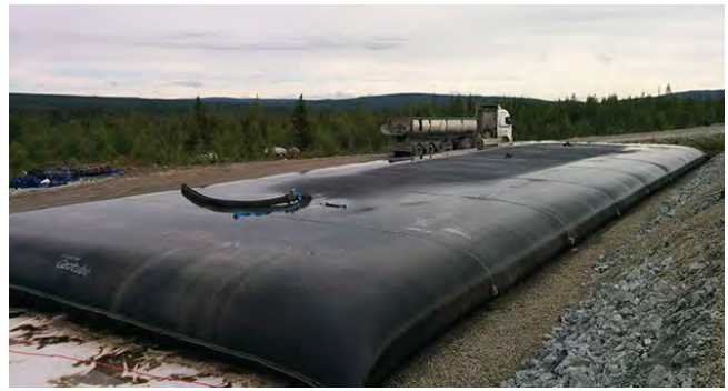
Figur 3.5.4 Geotuber vid Svärtrräskgruvan. Foto: SGU/Kristina Sjödin
