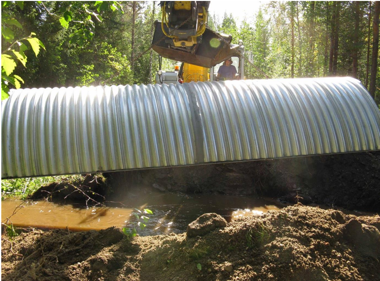
Figur 4 Utbyte avvägtrumma till en halvtrumma i samband med restaurering av vattendrag.
