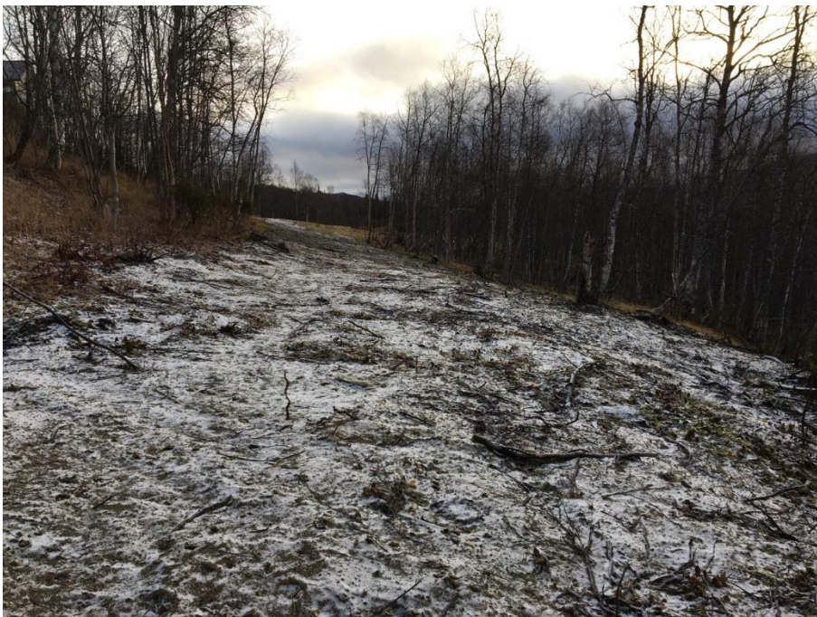
Figur 12. Schaktad morän från utförda VA-arbeten
