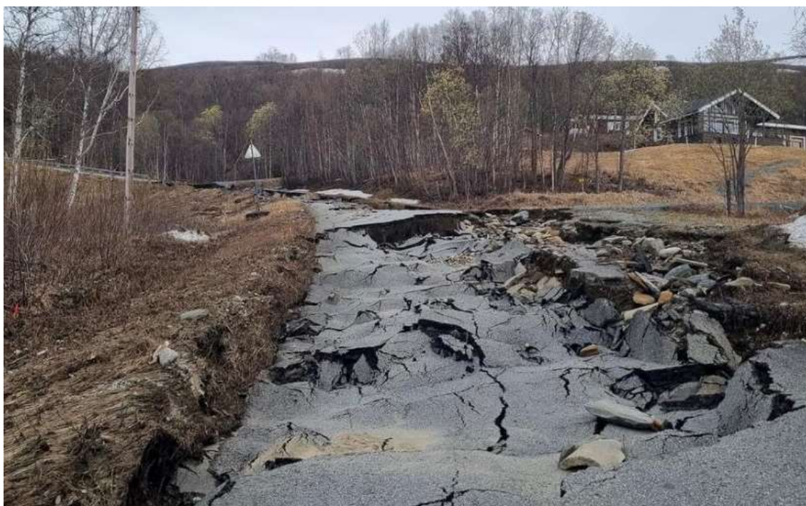
Bild 1. Kraftiga flöden och översvämningar kan leda till att vägar blir avskurna. Laisaliden 2024. Foto Ida Hagvall.
