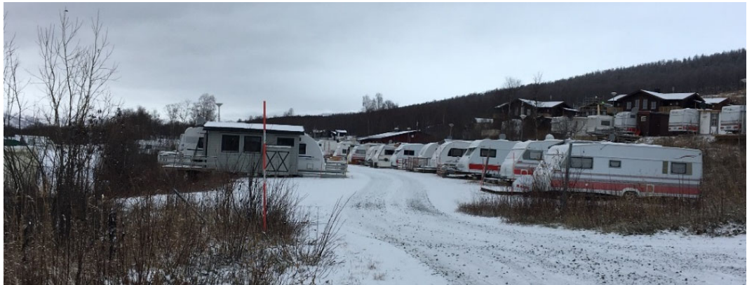
Fotot visar campingområdet och öster om detta pågår exploatering av Solbacken (Foto: Pethra Fredriksson Tyréns AB 2017-11-01)
