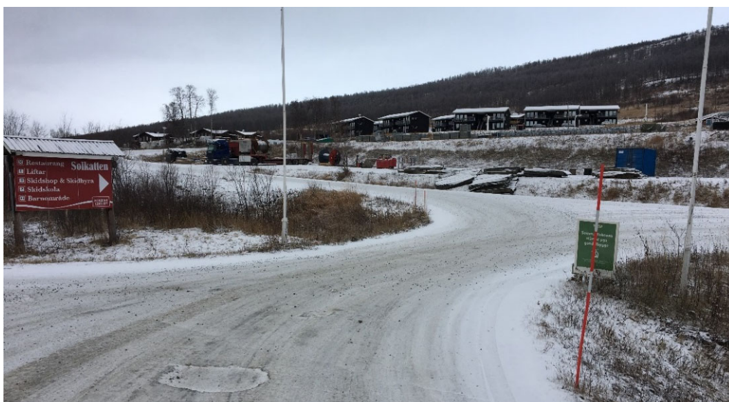
Fotot visar campingområdet till vänster i bild, nordöst om detta pågår exploatering av nytt fritidsbusområde Solbacken (Foto: Pethra Fredriksson Tyréns AB 2017-11-01)
