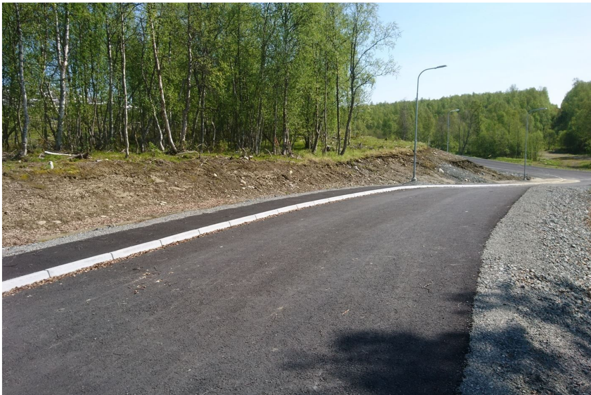
Figur 5: Bild tagen efter lokalgatan mot sydöst. Framtida förskola är tänkt att ligga till öster om lokalgatan. Foto: Ulrika Kjellsdotter.
