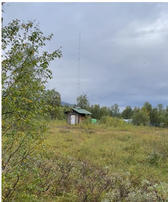
Foto på flygmast och tillhörande teknikbyggnad.
