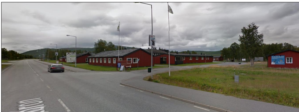
Vy från väg E12 vid norra infarten till Hemavans Fjällcenter, sydvästlig riktning. Google maps.
