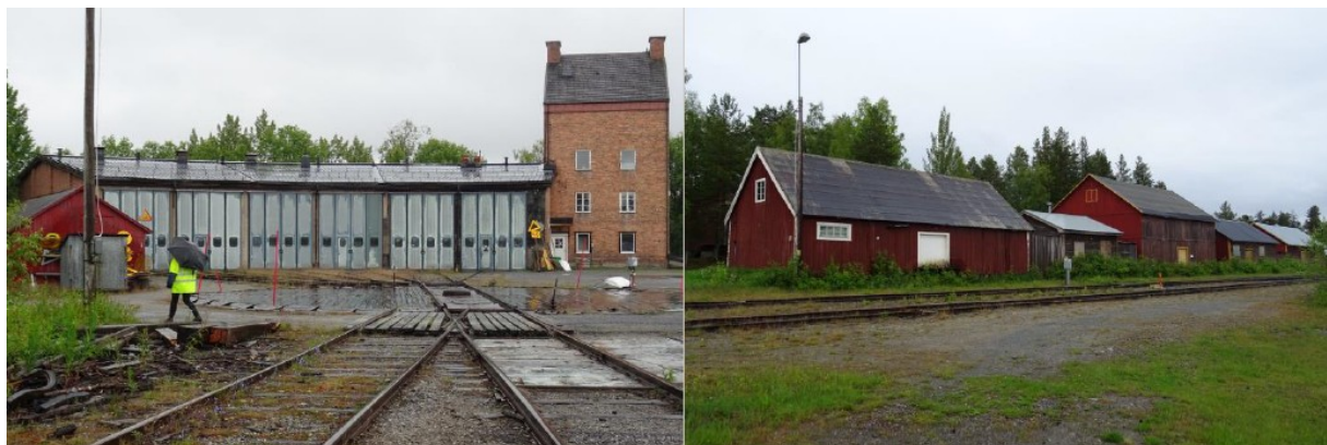
Figur 15: Utdrag från Trafikverkets rapport "Tre järnvägsmiljöer i Västerbottens län. Bild till vänster visar Lokstallet, bild till höger delar av järnvägsmagasinen.
