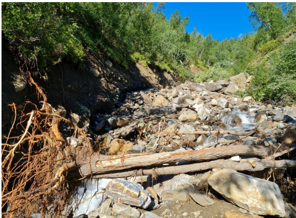
Bild 15. Foto efter Storängesbäcken öster om E12 (källa: SGI).
